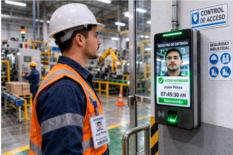
Fig. 15 Control biométrico de personal
